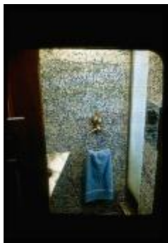
Tiled Bathroom Wall (KA0048_b01_f15_s15)
